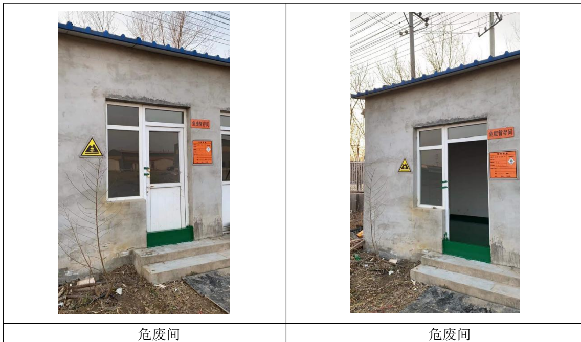
图 4-7 危险废物暂存间
